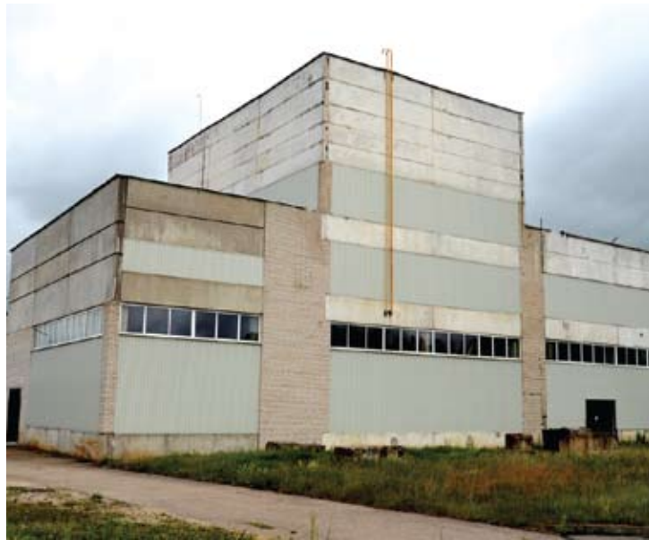
Čia bus montuojamas 4 MW biokuro katilas.
