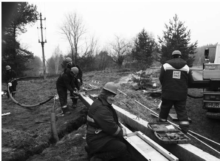
Uteniškiai ESO užsakyму dalį aukštos įtampos elektros perdavimo linijos pakeitė kabeliu.
