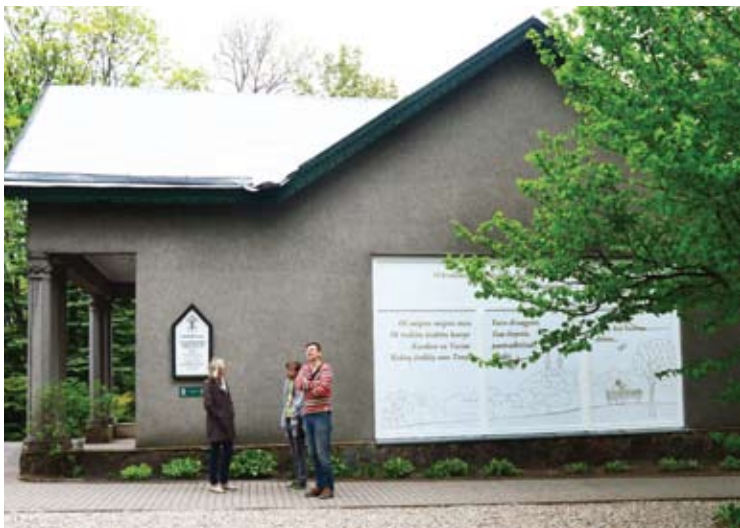
Balta spalva iš tolo šviečiančios keliolikos kvadratinų metrų instaliacijos visiškai uždengė A. Baranausko klėtelės vaizdą.
