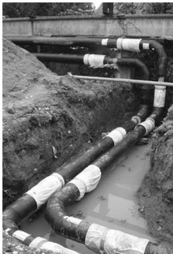
Dalį dvidešimt metų nenaudotų šilumos trasos į Pušyną vamzdžių teko pakeisti.
