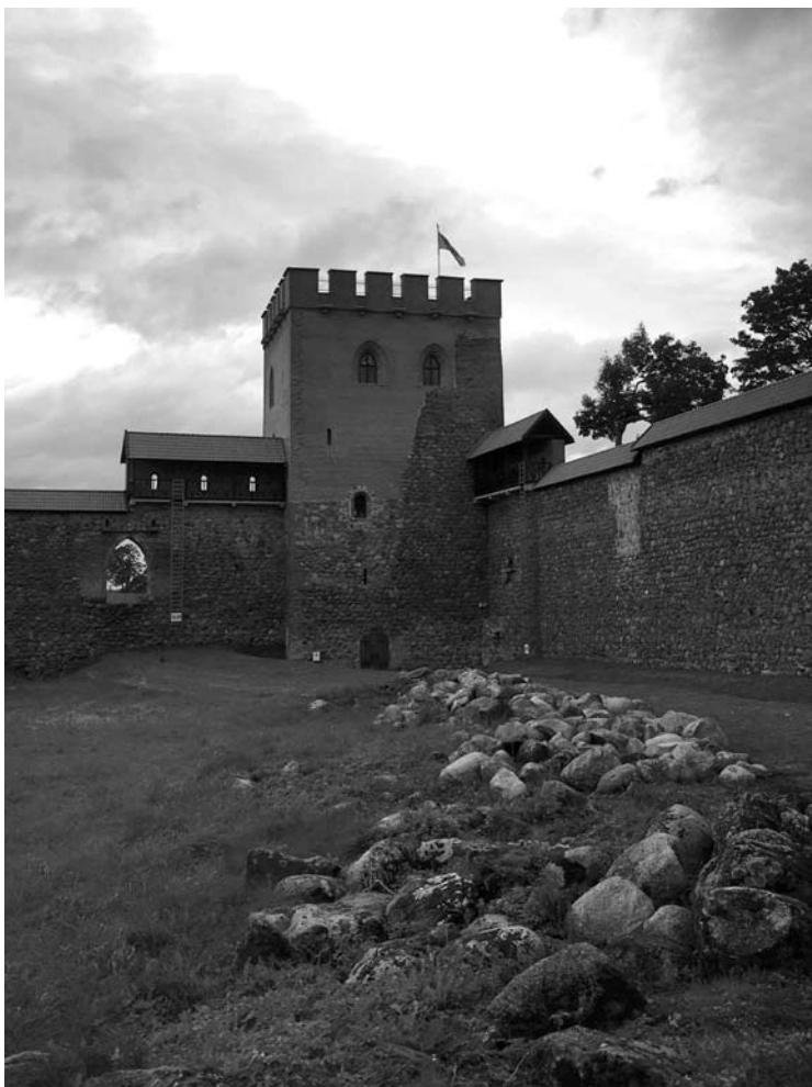
Rekonstruotoje Medininkų pilyje matosi ir autentiškų plytų fragmentų – bokštas sumūrytas skirtingomis plytomis.
