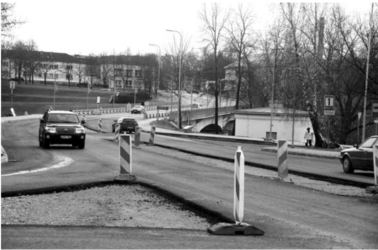
Statybininkai iki žiemos viliasi užlieti ir viršutinį asfalto sluoksnį Anykščių A. Vienuolio gatvėje.
