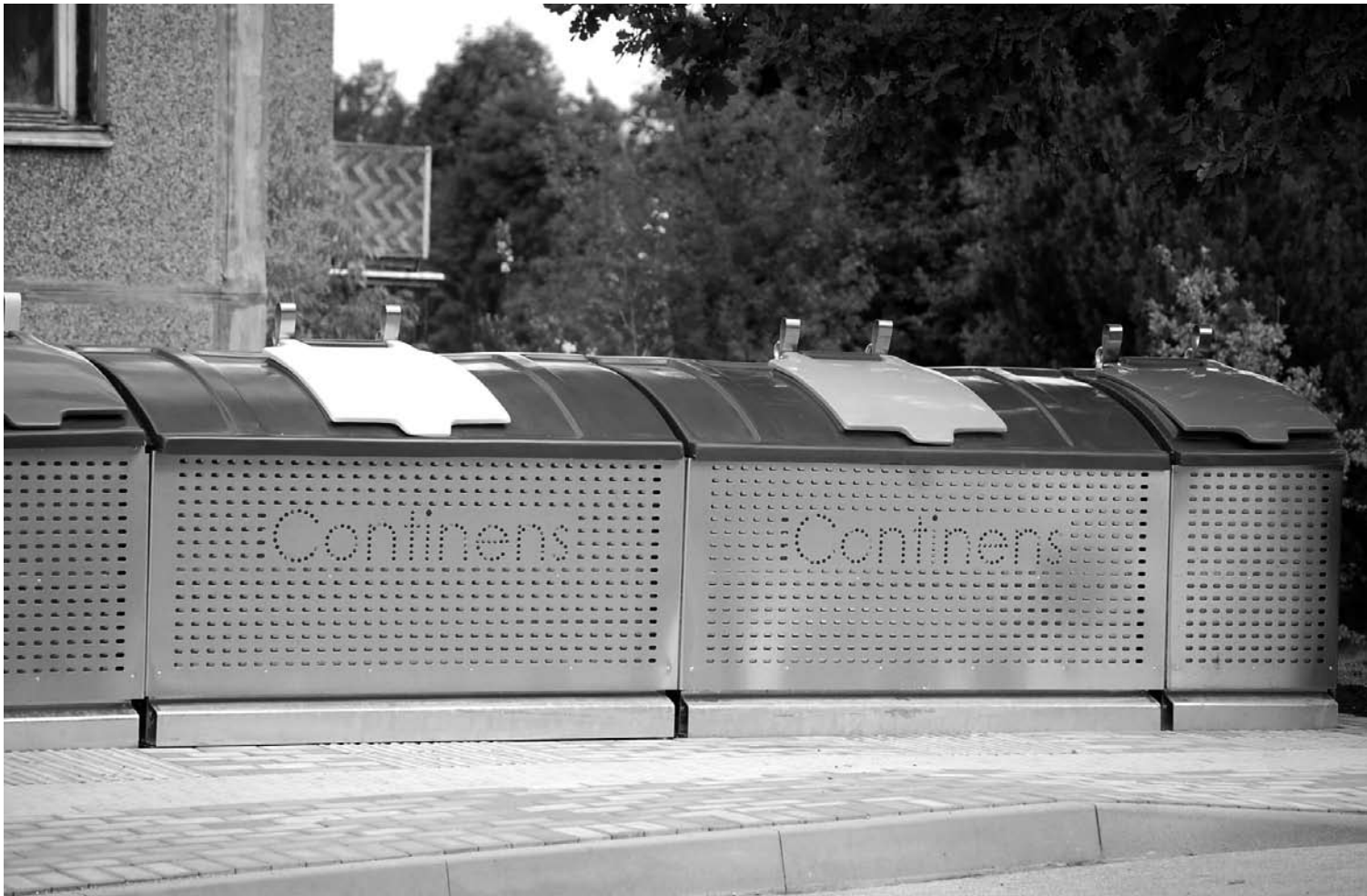
Pusiau požeminė konteinerių aikštelės, kurios bus įrengiamos Anykščių mieste. Aikštelė jau įrengta Ažupiečių mikrorajone.
