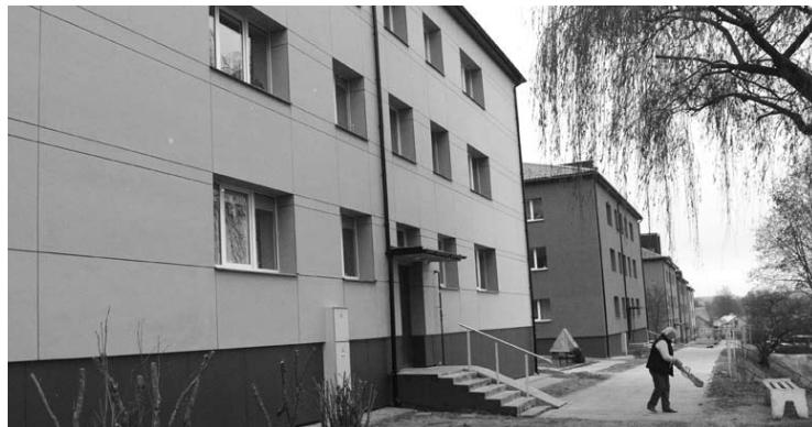
Anykščiuose, A. Vienuolio gatvėje, vienu ypu renovuotas penkių daugiabučių namų kvartalas.
