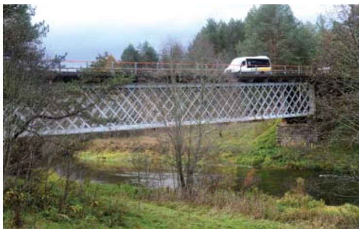
Kaimo įžymybė – 1872 metais pastatytas Mickūnų tiltas, kuriam gelžbetoninį paklotą 1923 m. suprojektavo iš Andrioniškio kilęs inžinierius Pranas Markūnas.
