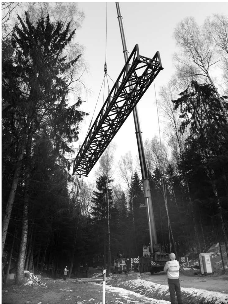
20 metrų ilgio ir 6,5 tonos sveriančios tako konstrukcijos montuojamos pasitelkus 200 tonų keliamosios galios autokraną.
