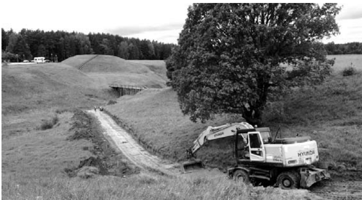
Medinės pilies statyboms reikalinga sunkioji technika judės laikinuoju žvyro keliu. UAB „Termotaupa“ statybos direktorius Romualdas Vitkus neatmeta, kad eksploatuojant šį kelią dėl lietaus gali tekti jį tvarkyti dar ne vieną kartą.
