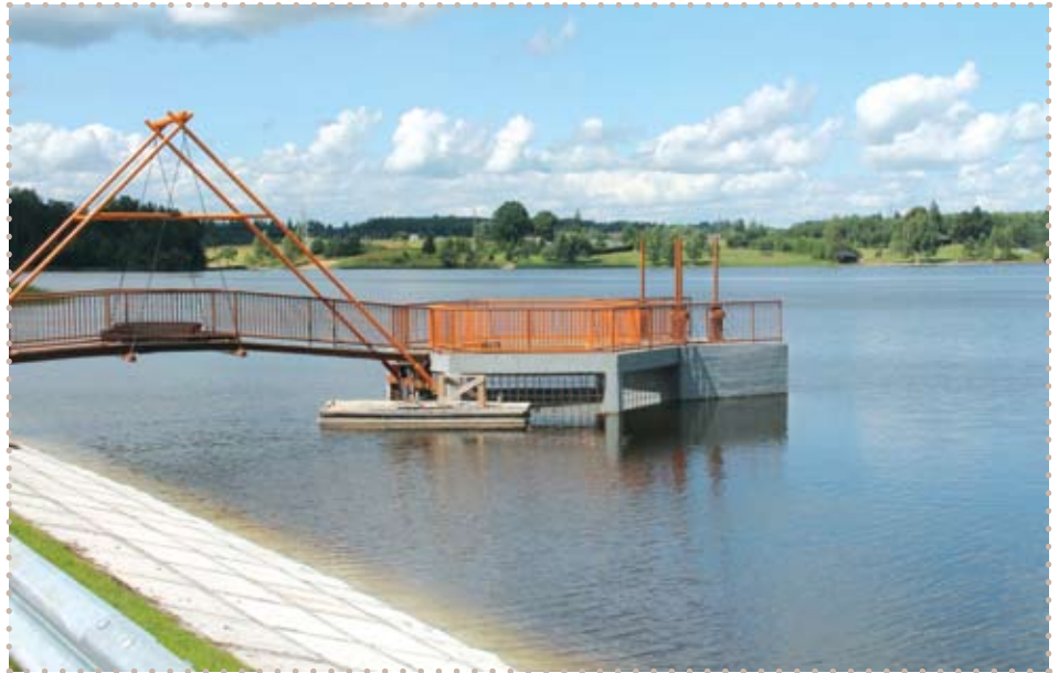
► Įgyvendinant projektą, sutvirtinta vidinė šachtos pusė.
